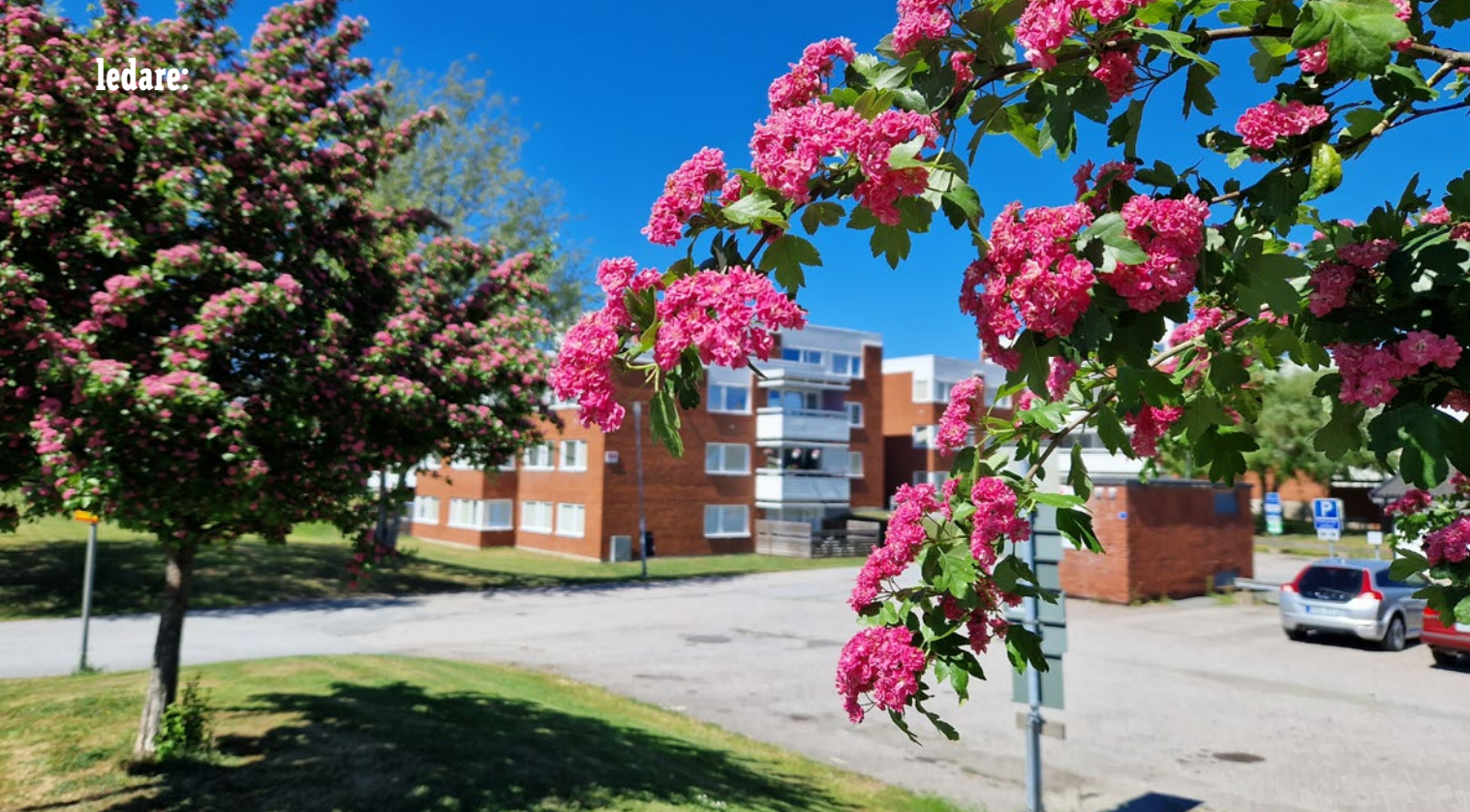
Kvarteret Väster Knutby – Roslagsbostäders första nybyggnation i Norrtälje står inför ett stambyte under de kommande tre åren.
