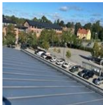
På Kajen i Rimbo har vi målat tak och plåtdetaljer.
